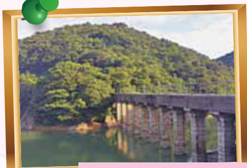
大潭上水塘石橋輸水道 Tai Tam Upper Reservoir Masonry Aquaduct
